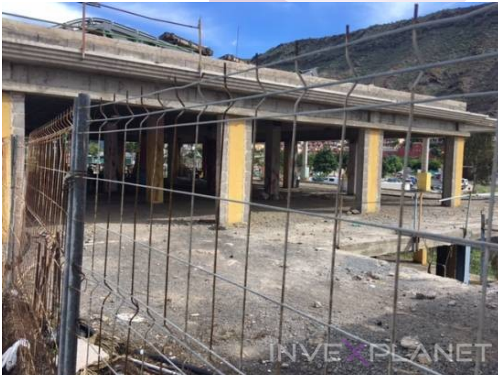
VISTA ESTADO ACTUAL INMUEBLE
