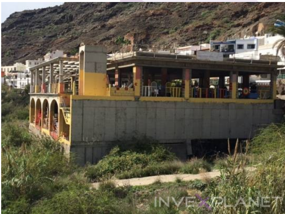
VISTA ESTADO ACTUAL INMUEBLE
