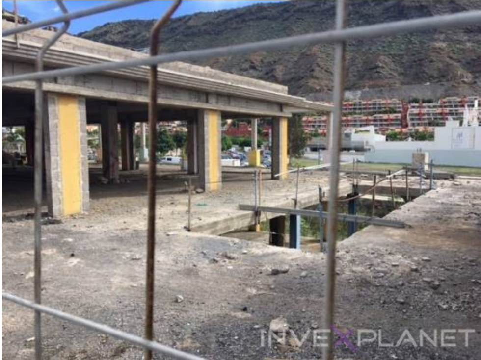
VISTA ESTADO ACTUAL INMUEBLE
